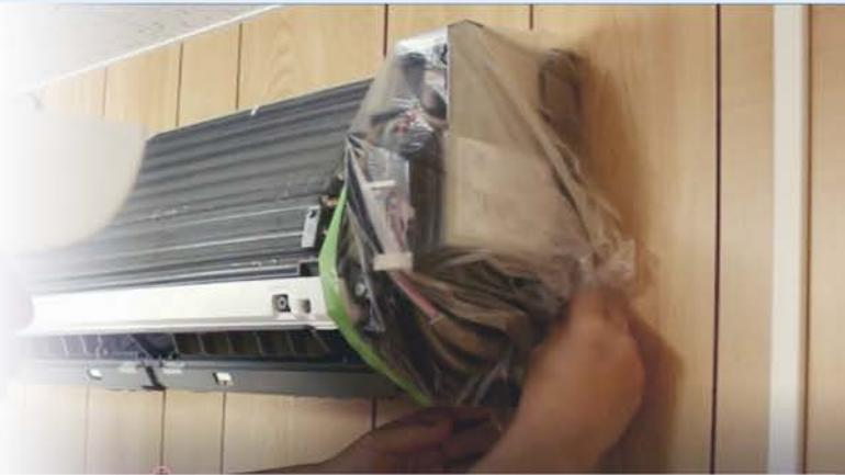
基盤部分に水分がかからないように養生していきます。まわりをぐるりとひとまきし、ビニールを後ろに差し込むようにします。
