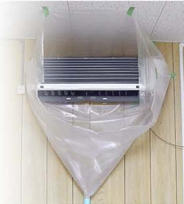
エアコン上部を養生します。天井に2箇所、開口を確保するようにテープでとめます。両サイドのカバーと養生もテープでとめ、遊ばないようにします。
