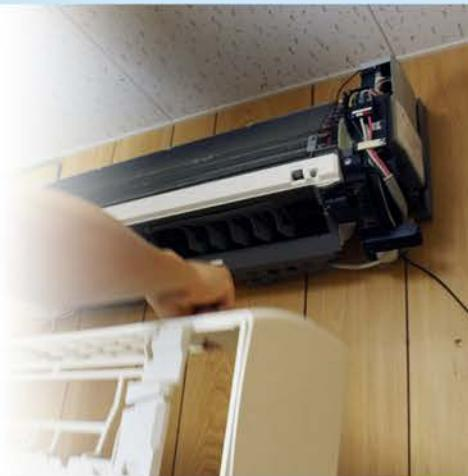
まず①電源からコンセントを抜き、②エアコン集塵フィルターを外します。③次に前面パネルを外したら、本体のビスを外します。④次にルーバーを外すのですが、古いエアコンですと、**プラスチックが劣化している為割れやすくなっている**ので注意が必要です。ルーバーを取り外したら、⑤基盤のカバーも取り外します。⑥本体カバーやルーバーなどの外装パネルは中性マルチクリーナーで洗浄します。本体カバーは、上部にツメなどがありますので、それを外して取り外します。
