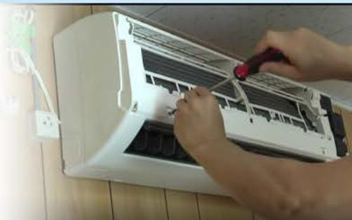
クロスでしっかりと水分を拭き取ります。届かない部分はエアーダスターを使い水分を吹き飛ばすのも有効です。養生をすべて取り外したら、洗い終わったエアコン本体のカバーをすべて取り付けます。
