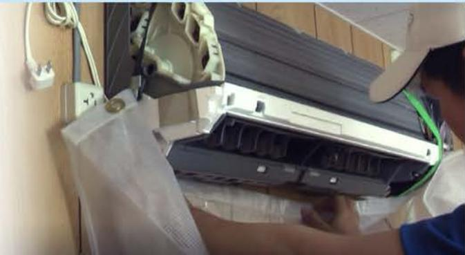
壁とエアコン本体の隙間に養生カバーを差し込みます。
